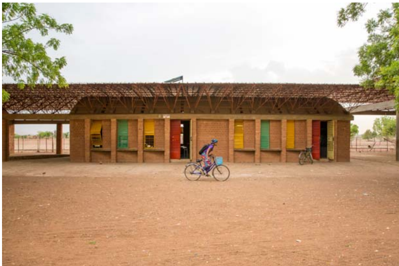
Francis Kéré Erweiterungsbau der Schule in Gando, Burkina Faso, 2016 Foto: Daniel Schwartz/Gran Horizonte Media
